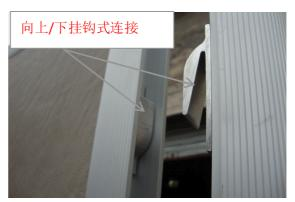
第三步: 重复相同的操作,安装 No.3-No.8 墙板
